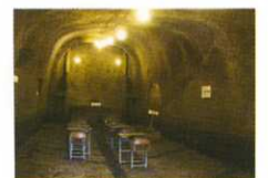
天井部分から作りはじめ、掘り上げていったという見事な空間。
